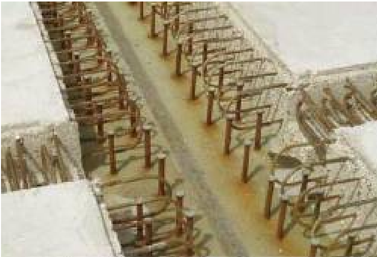
Impalcati bi-trave con traversi solidali alla soletta
