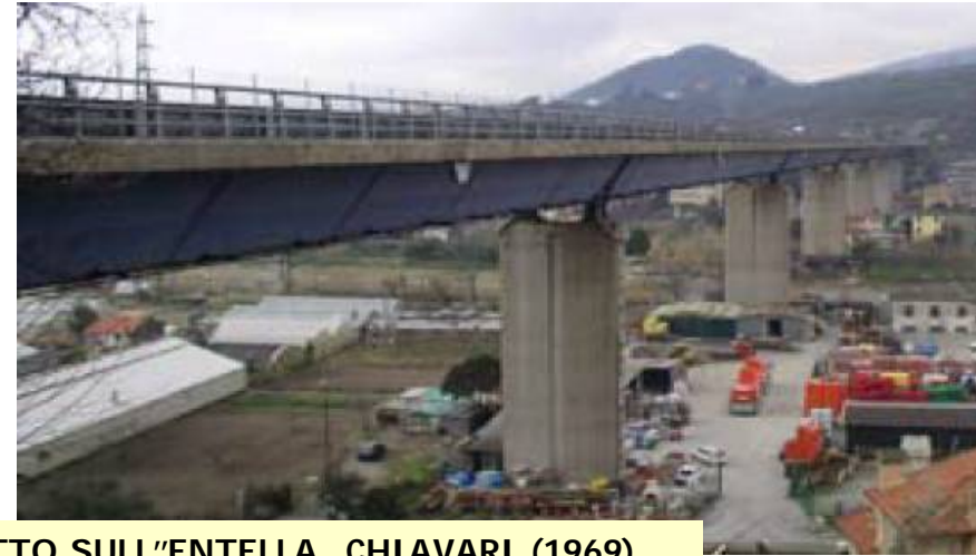
VIADOTTO SULL'ENTELELLA, CHIAVARI (1969)
