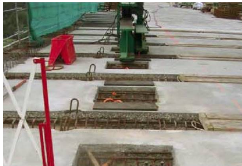
Impalcato bi-trave con traversi non solidali alla soletta
